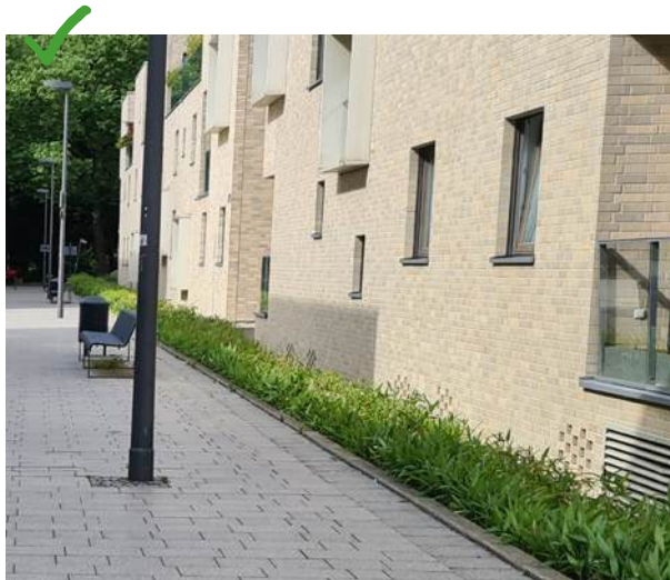
wel: overgangszone privé-openbaar bij een appartementengebouw is groen ingevuld
