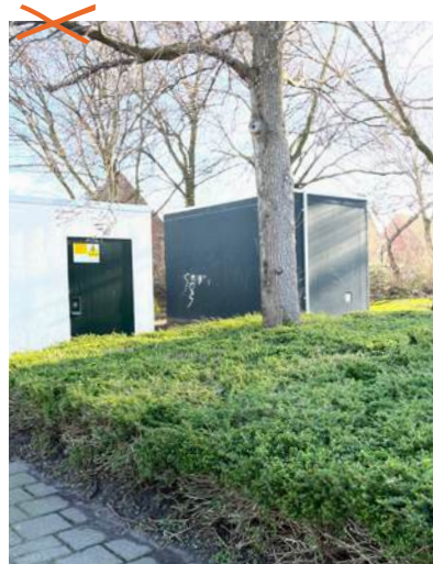
niet: losse trafo's in de openbare ruimte
