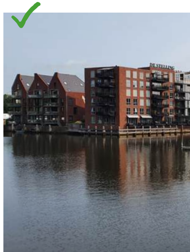
wel: variatie in daklandschap, hoofdmateriaal baksteen
