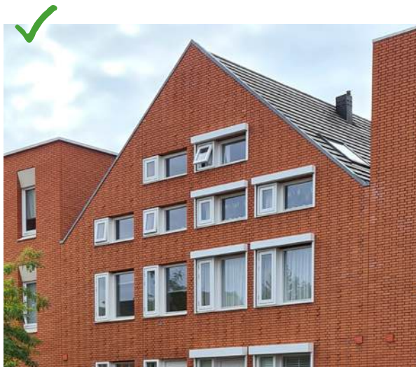
wel: afvoeren geclusterd in een dakdoorvoer
