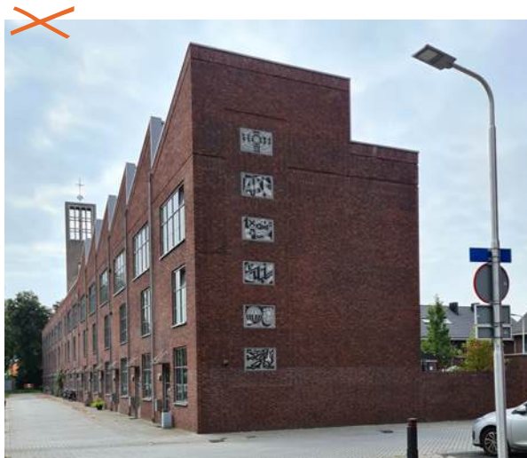
niet: blinde kopgevel
