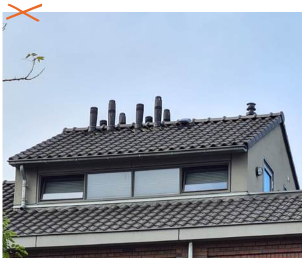
niet: veelheid van losse dakdoorvoeren
