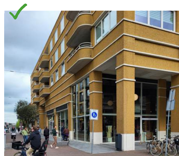
wel: beperkt uitstekende balkons over het openbaar gebied vanaf de tweede verdieping
